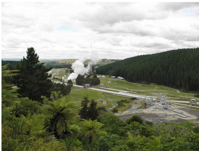
写真 8 ワイラケイ地熱発電所 熱水を運ぶパイプライン網
